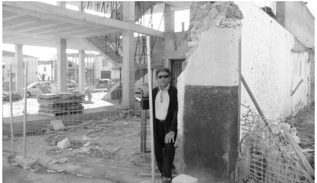
Zerstörte Häuser bei Lorca 2006. Inzwischen sind die Trümmer beseitigt.
