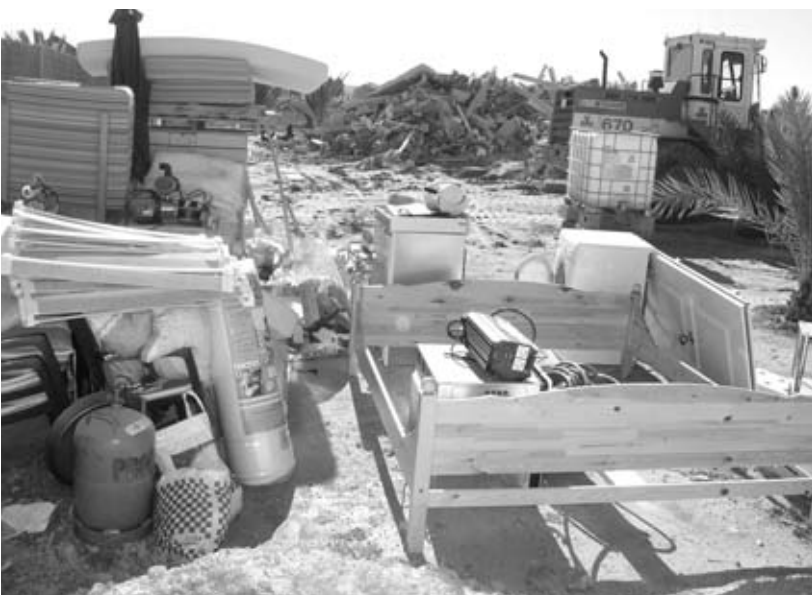
Die Überreste des Abrisses.
